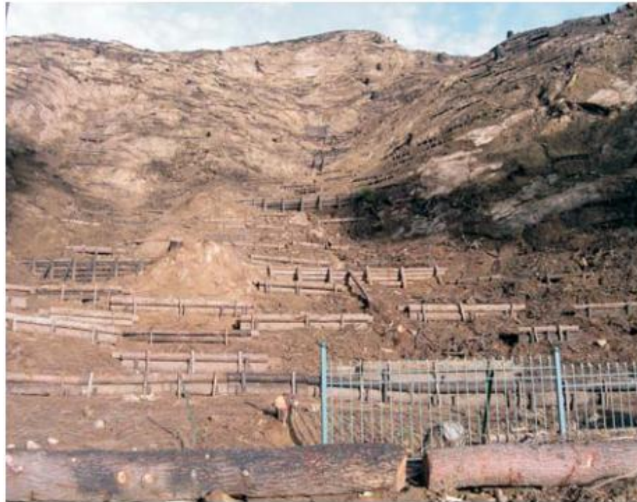
Προστασία παλαιάς γεωλίστεσης στη νότια πλευρά του Κρόνιου λόφου, με την κατασκευή κορμοφραγμάτων και κορμοδεμάτων (2-11-2007).
