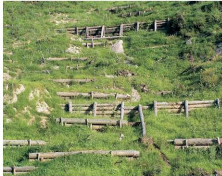
Εγκατάσταση πλώδους βλάστησης μετά από υδροσπορά στη νότια πλευρά του Κρόνιου λόφου (15-4-2008).
